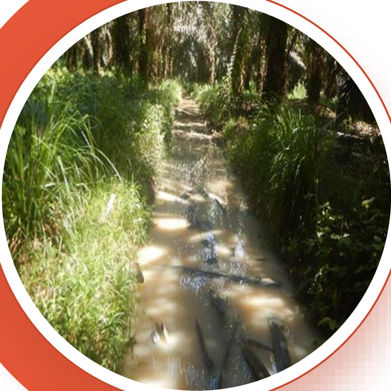
Drenaje sin mantenimiento
